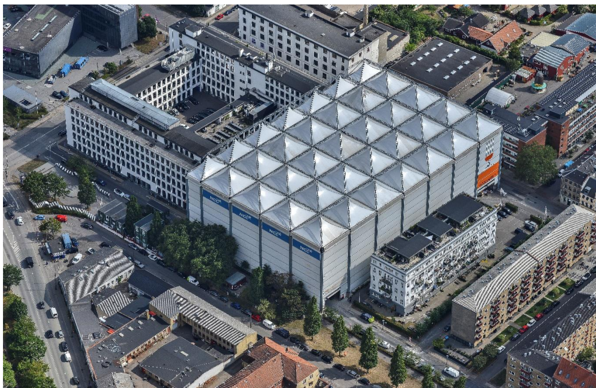
Luftfoto af byggepladsen
